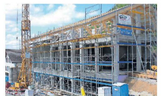
Der Rohbau der neuen Wasserfluhgarage AG steht.
