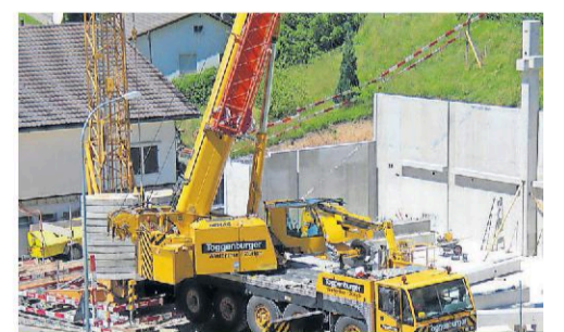
Die Bauarbeiten für den Neubau beginnen.
